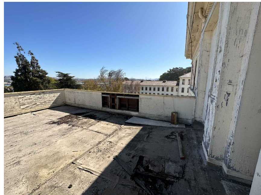
7 PORTE COCHERE ROOF EDGE
